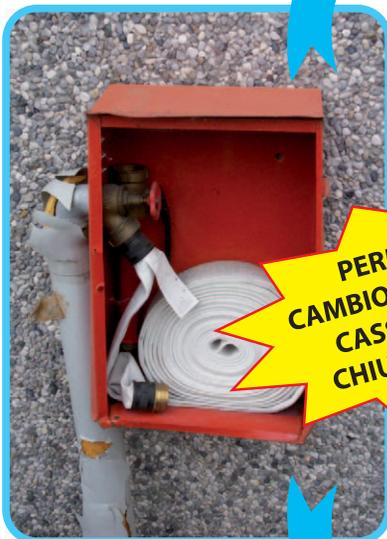
Togliendo le lamiere pretagliate sul lato e sul retro della cassetta la si può installare con la tubazione all'esterno della stessa senza dover smontare il rubinetto.
